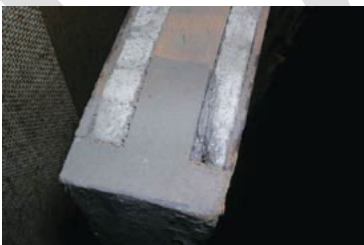
Asbestos panels 'millboard' inside a fire door
